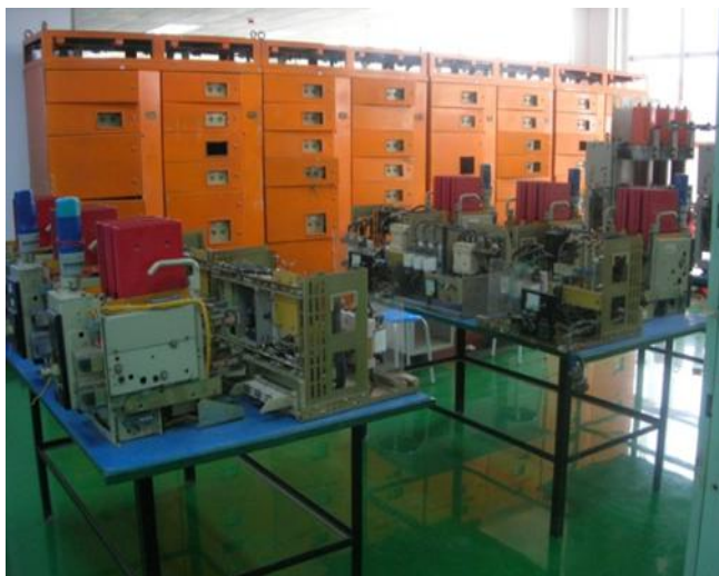
高低压开关设备检修实训室
