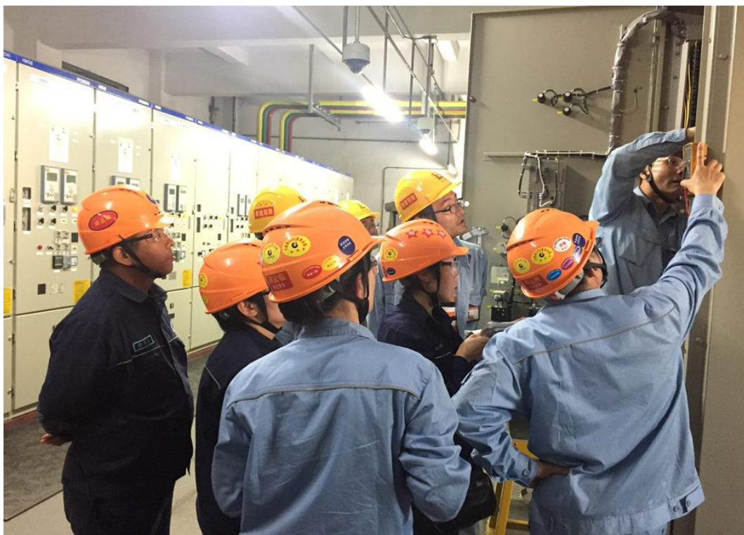
岳阳长炼机电工程技术有限公司员工现场送变电线路及配电设备的安装培训
