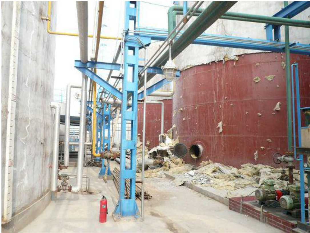
技术改造施工现场
