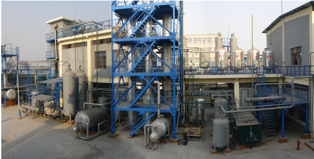
主持改造的兰州红叶精细化工公司 T601 装置多元非均相共沸精馏系统
