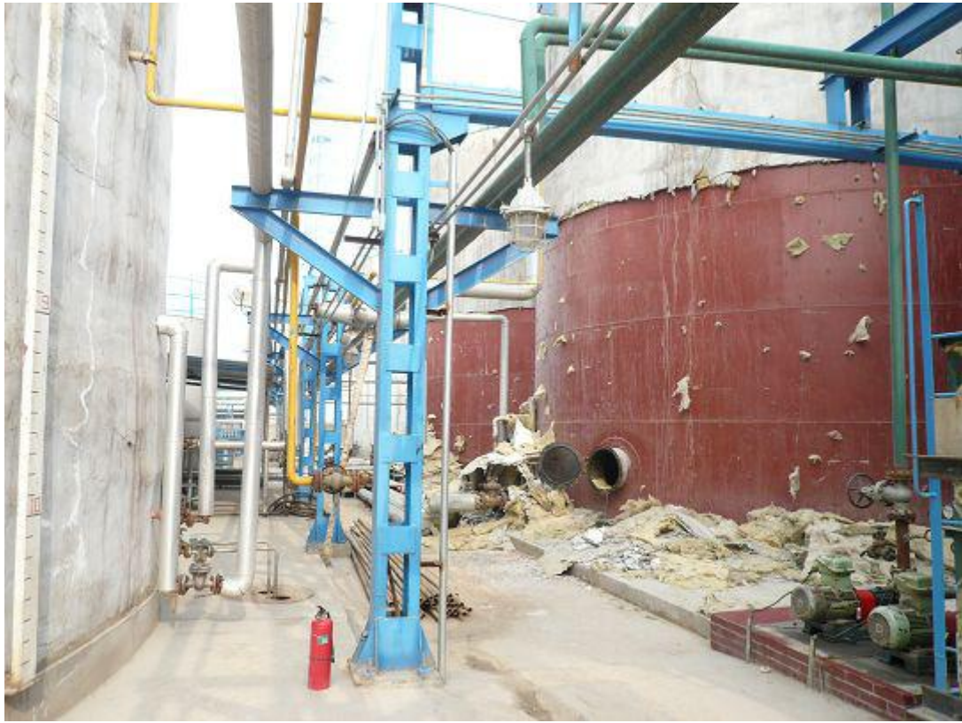
技术改造施工现场
