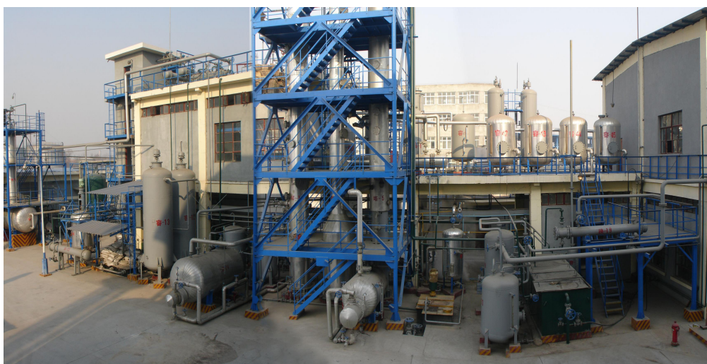
主持改造的兰州红叶精细化工公司 T601 装置多元非均相共沸精馏系统
